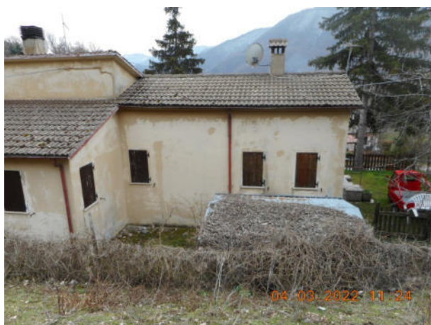
Esterno lato nord
